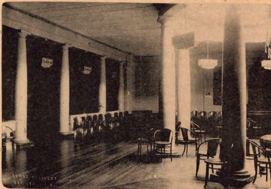
CASA DE ESPAÑA.—Vista de la mitad del Salón de Actos.
